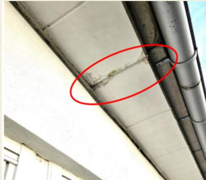
Bild 1 & 2. Synlig fuktgenomträngning i undersida terrass/takfot över balkong
