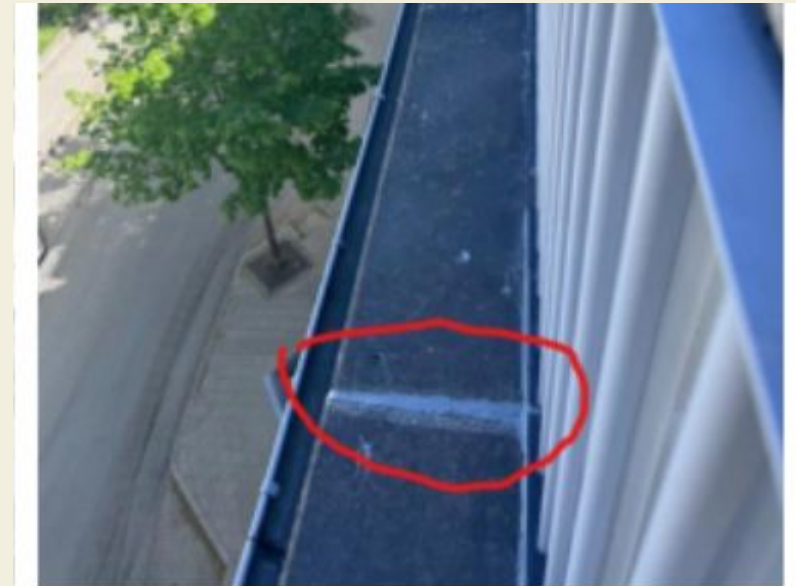
Bild 1 & 2. Synlig fuktgenomträngning i undersida terrass/takfot över balkong
