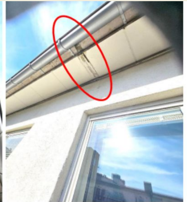
Bild 1 & 2. Synlig fuktgenomträngning i undersida terrass/takfot över balkong
