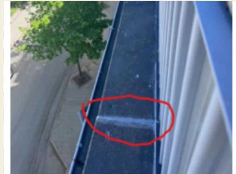
Bild 1 & 2. Synlig fuktgenomträngning i undersida terrass/takfot över balkong
