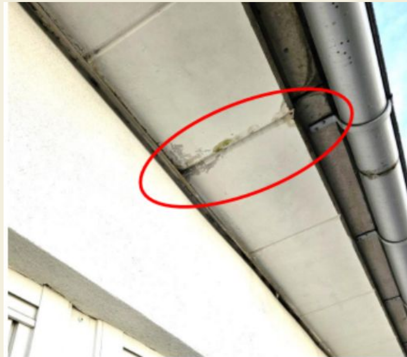
Bild 1 & 2. Synlig fuktgenomträngning i undersida terrass/takfot över balkong
