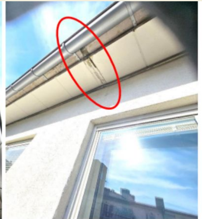
Bild 1 & 2. Synlig fuktgenomträngning i undersida terrass/takfot över balkong
